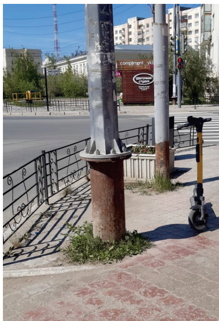
Рис. 1. Выпученная стальная опора уличного освещения в г. Якутске
